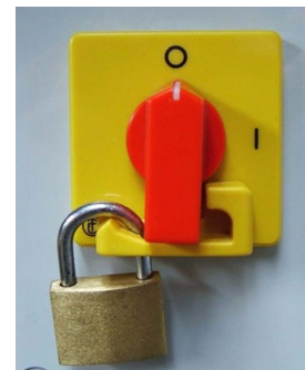
Abb. 43: Hauptschalter gesichert
