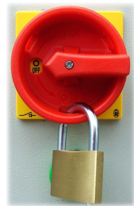
Abb. 22 Hauptschalter gesichert
