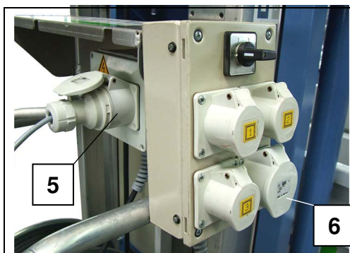
Fig. 19 Raccorder la boîte de distribution
